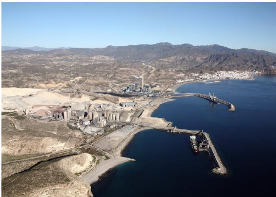
Ilustración 43. Central térmica Carboneras 51
