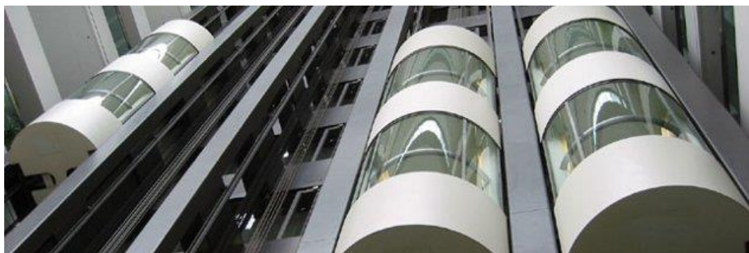
Figura 9.- Ascensor Double Deck
