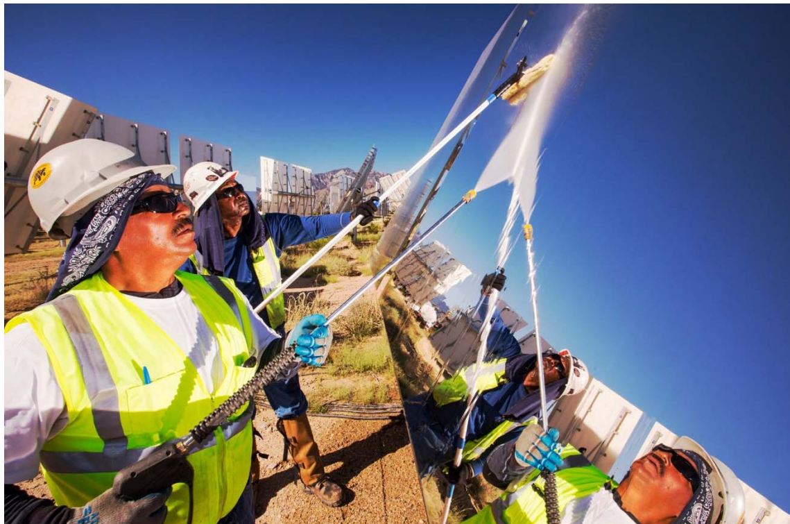
Figura 16. Limpieza con agua a presión. Fuente: infobae.com
