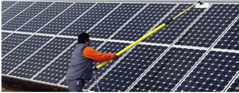
Figura 15. Limpieza con pértiga y agua. Fuente: limpiezaplacassolares.com
