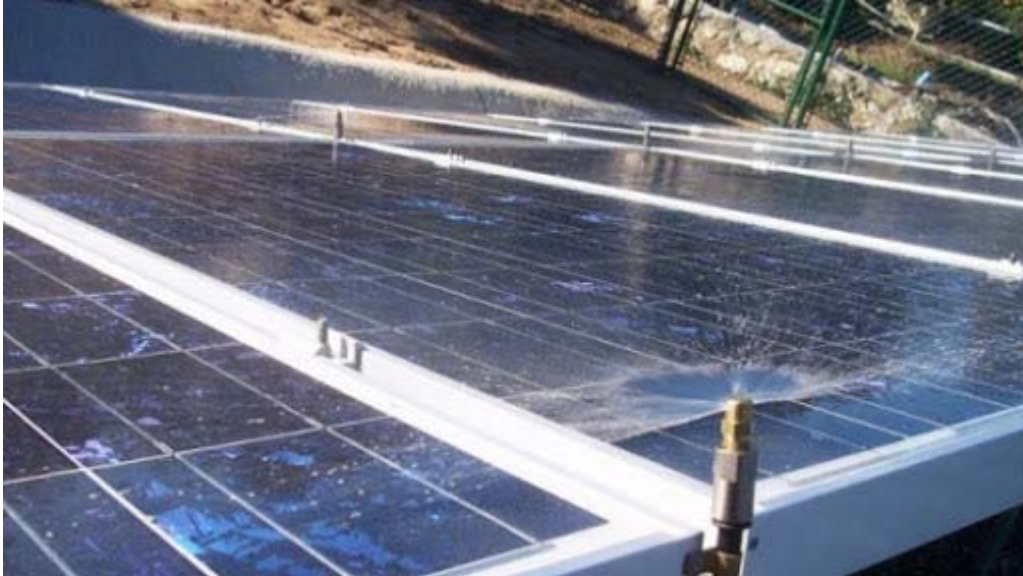
Figura 19. Limpieza mecánica automatizada. Fuente: Google
