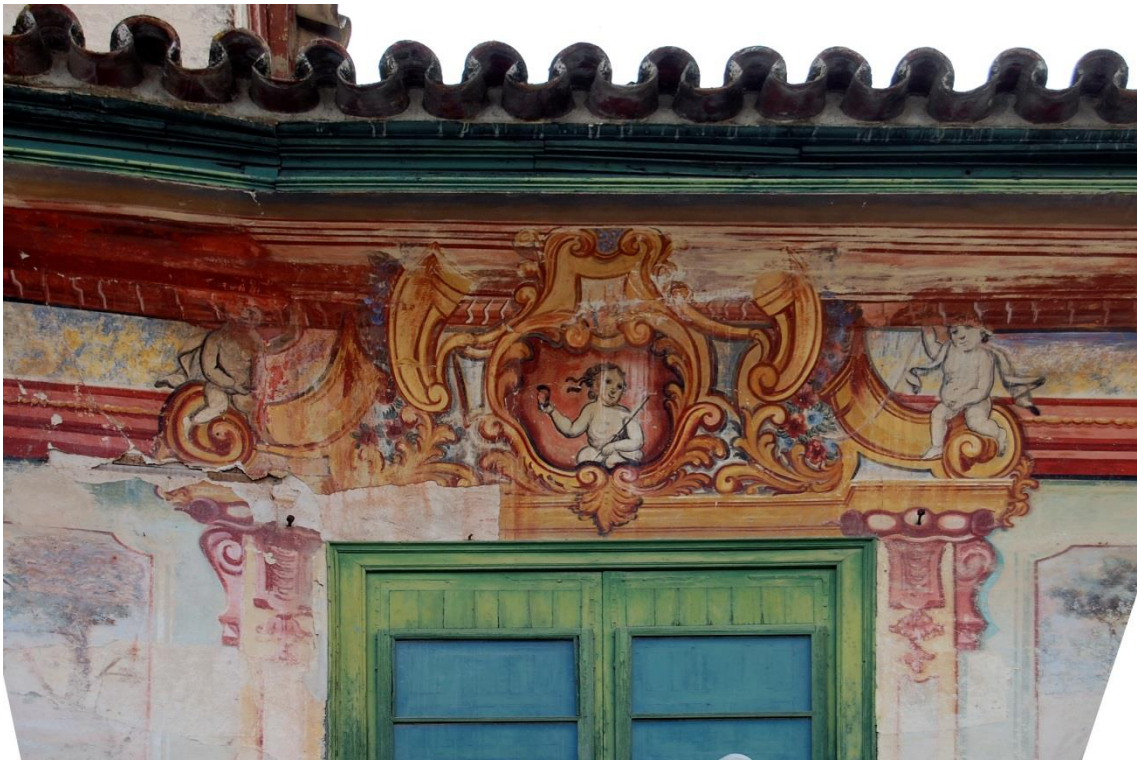
Figura 17.1 (Detalle de decoración previo a la restauración virtual)
