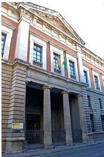
Imagen nº 27 Fachada del Archivo Histórico Provincial de Sevilla (2015), recuperado de https://www.google.es/search?q=archivo+historico+provincial+de+sevilla
