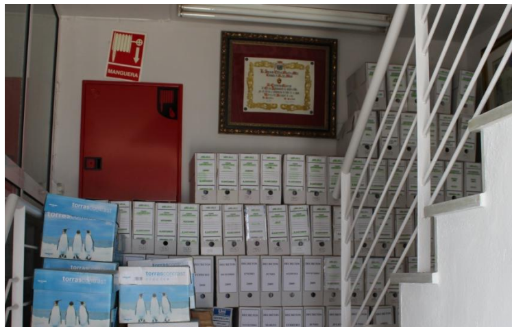
Imagen nº 8 Muñoz, C. (2015), manguera contra incendio. Archivo Municipal de Utrera
