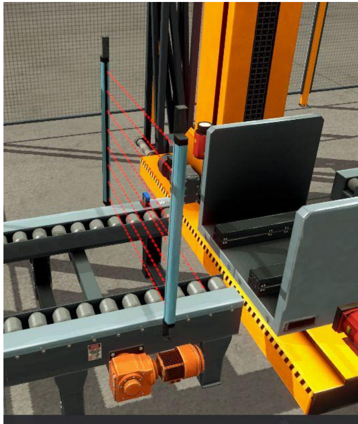
Figura 28. Sensor de alturas a la entrada del almacén automatizado.
