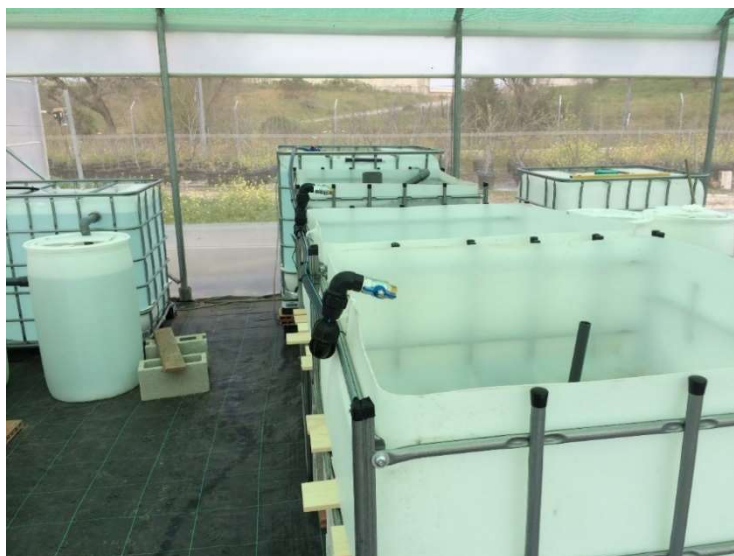
Ilustración 20. Sistema mixto después de su montaje con los materiales citados anteriormente.
