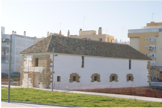
Fig.1: Edificio del s. XVIII tras una intervención de rehabilitación.
