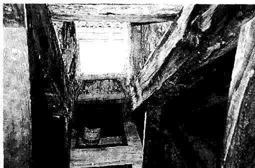
Figura 12 Tramo recto del ábside. Hueco de ventilación
