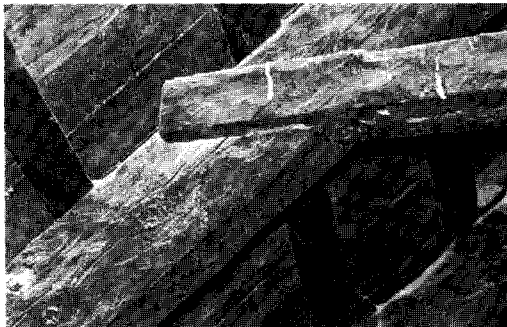
Figura 3 Unión par-nudillo a media madera
