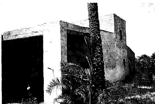
Figura 5 Casa con tejado plano
