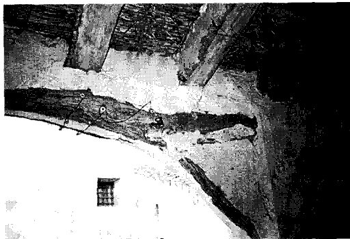
Figura 12 Vigas de tronco de palmera y olivo
