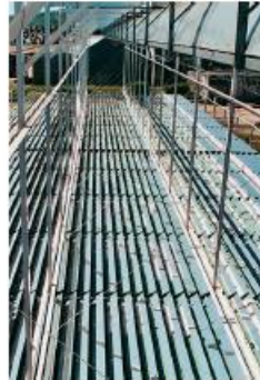
Pegado de acero a la estructura resistente de una planta solar térmica.
