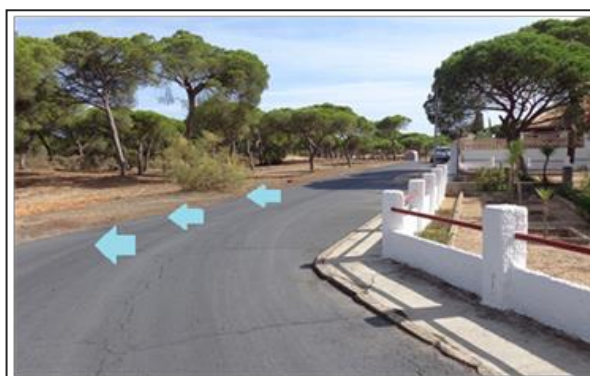
Fig. 4 Vial perimetral en Pinos del Mar
