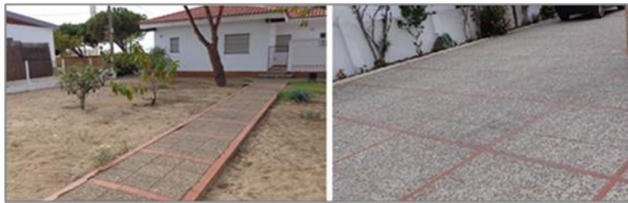
Fig. 8 Zonas de paso peatonal y arenas, e impermeabilizaciones de patios en La Canaleta
