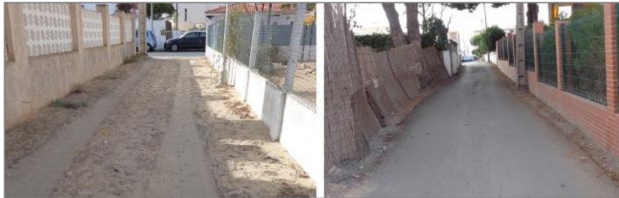
Fig. 7 Calle de arena con franja de paso peatonal y calle asfaltada en La Canaleta
