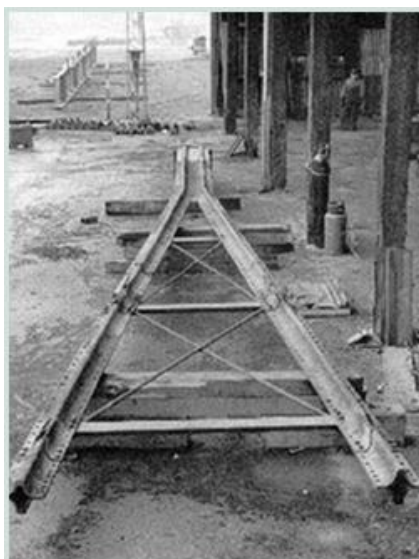
Fig. 9 Reparación de caballete o soporte del muelle. ( https://www.ethex.org.uk . 2016)
