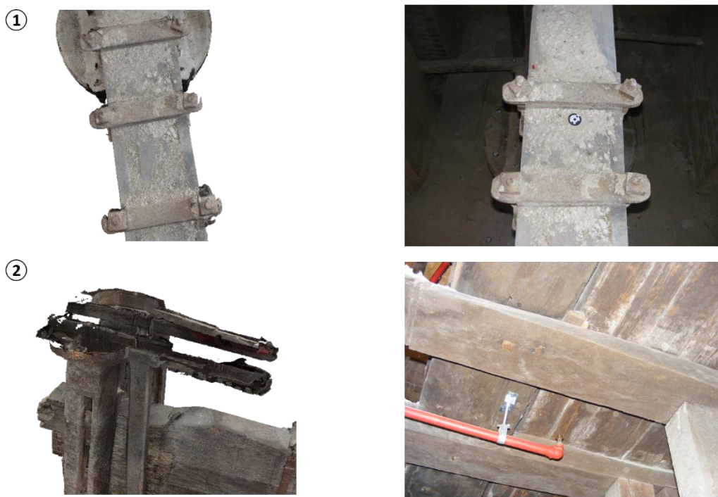
Figura 70. Defectos en restitución (izquierda) imagen real (derecha): (1) defectos en abrazaderas y tuercas y (2) defectos en guideras superiores de la Prensa.
