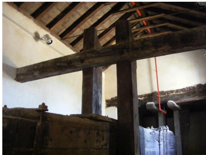
Figura 35. Parte final de la viga con malas condiciones de iluminación.
