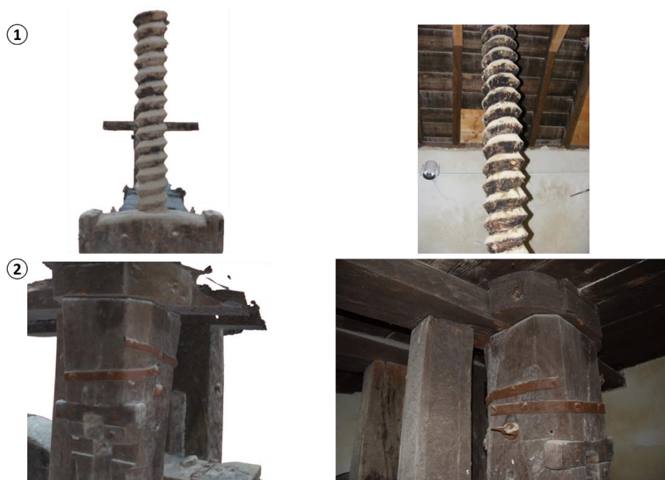
Figura 71. Restituciones (izquierda) imagen real (derecha): (1) husillo y (2) parte final de la viga.
