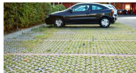
Figura 9. Ejemplo de aplicación de pavimentos permeables en zonas de poco tránsito. Fuente: City University of New York
