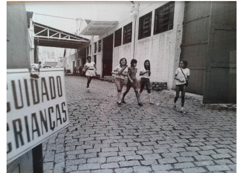
Figura 4. Fotografía estado previo a la intervención. SESC Pompeia.
