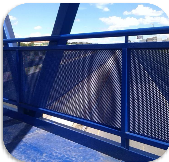
Figura 22. Detalle de la barandilla de seguridad.
