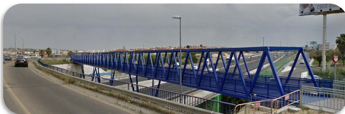
Figura 15. Vista de la pasarela ya construida desde el puente de la carretera A-8062. Fuente: Google Maps.
