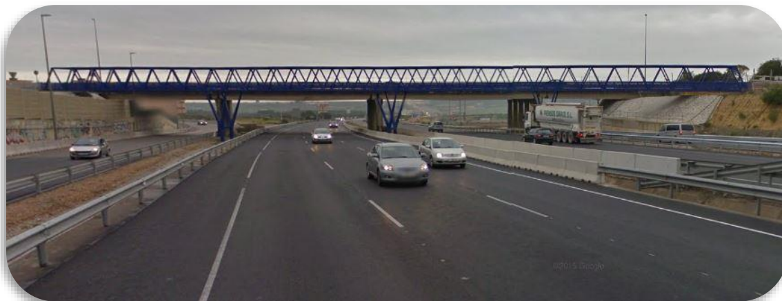
Figura 12. Alzado de la pasarela desde la autopista a la que dota de permeabilidad. Fuente: Google Maps.
