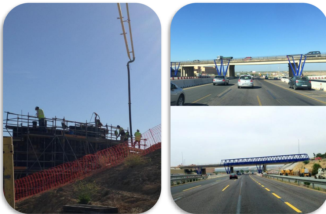
Figura 14. Fases generales de la construcción de la pasarela: bombeo de pilotes y estribos, colocación de pilas y disposición por tramos de la celosía y el tablero. Fuente: Blog de Songea-Laboratorio de Control de Calidad.
