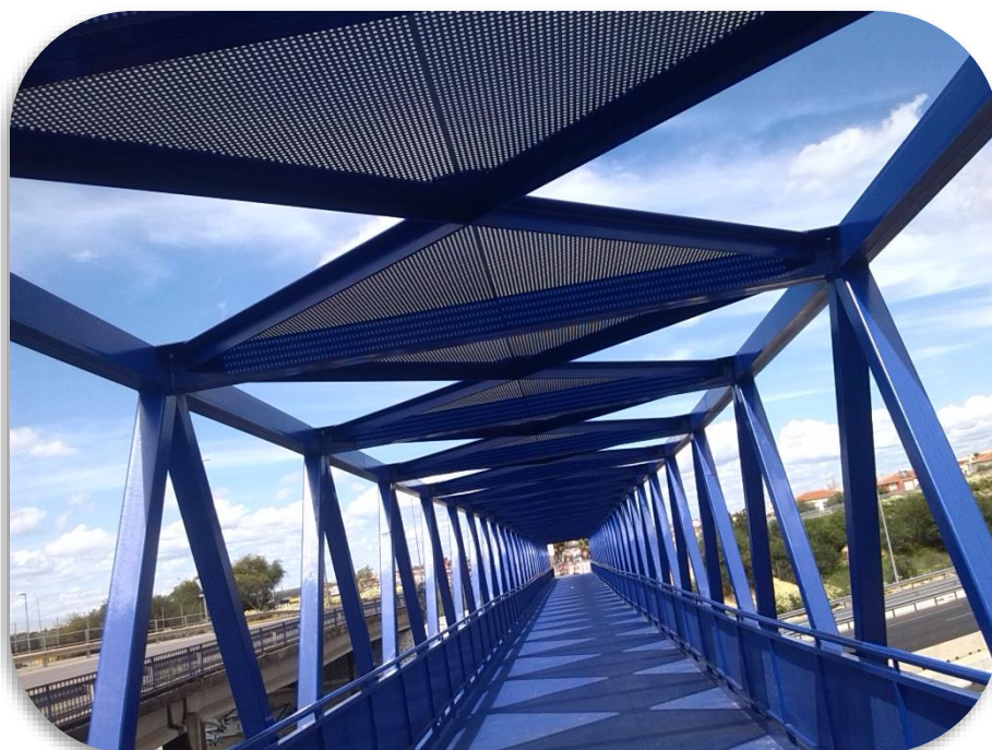
Figura 21. Vista interior de la pasarela.
