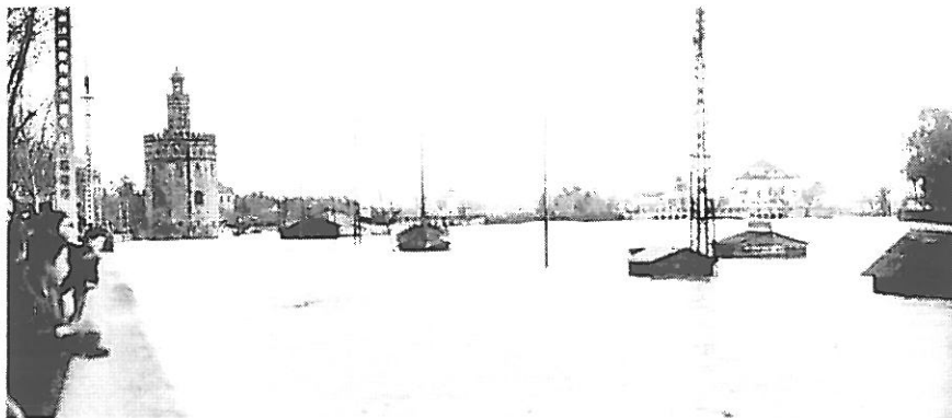
Figura 5.- Inundación en Sevilla (1947) afectando a la Torre del Oro (Sevilla-Equipo 28, 1990).
