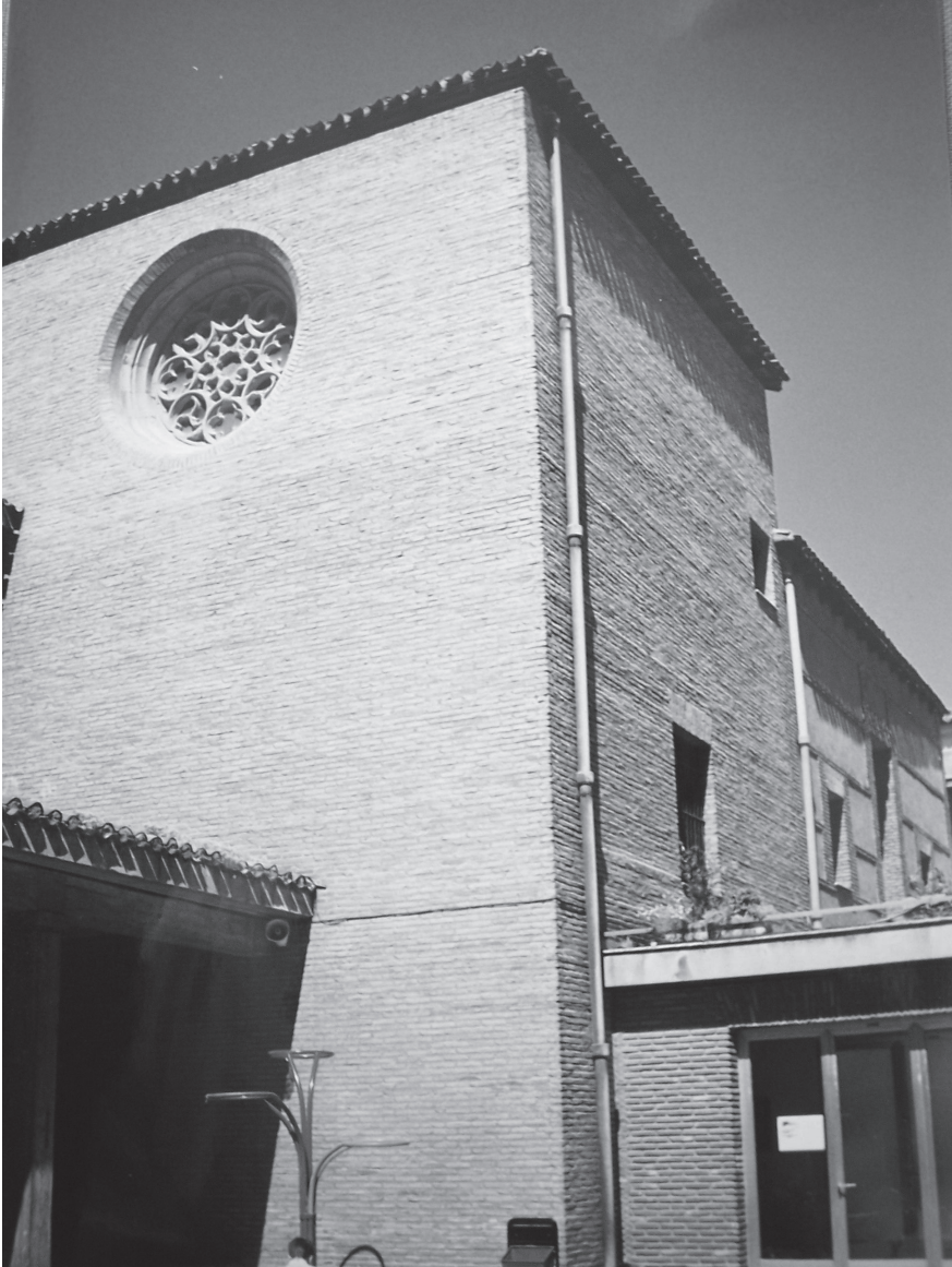
Figura 3. Torreón del monasterio de Las Huelgas de Valladolid.
