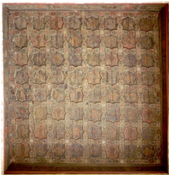
Figura 1. Alfarje de la esquina noroeste del Patio Principal del Palacio de las Dueñas (Sevilla). Entre finales del siglo XV y principios del siglo XVI. Fundación Casa de Alba.
