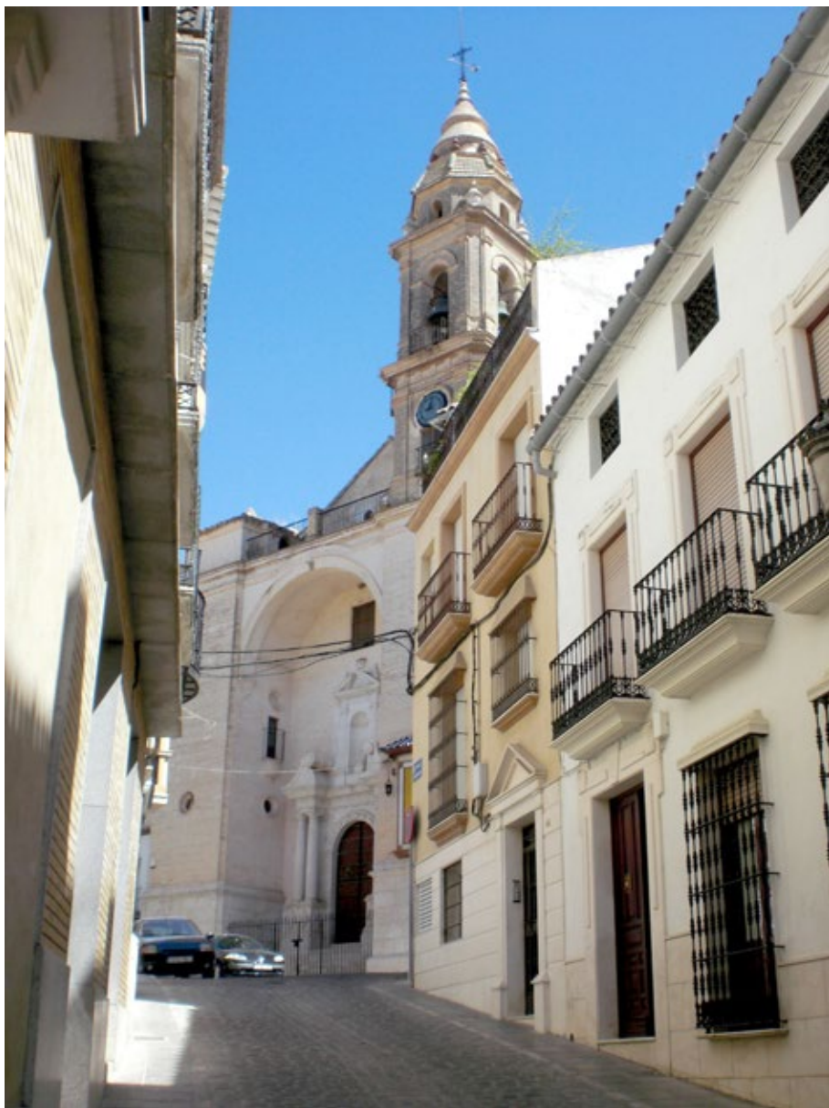
Figura 9. Puente Genil. Vista de la fachada del Santuario de Ntra. Sra. de la Concepción desde la Cuesta Baena.
