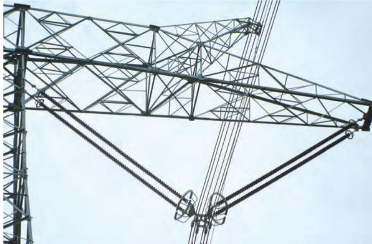
Figura 6: Aislador con forma de V [49]
