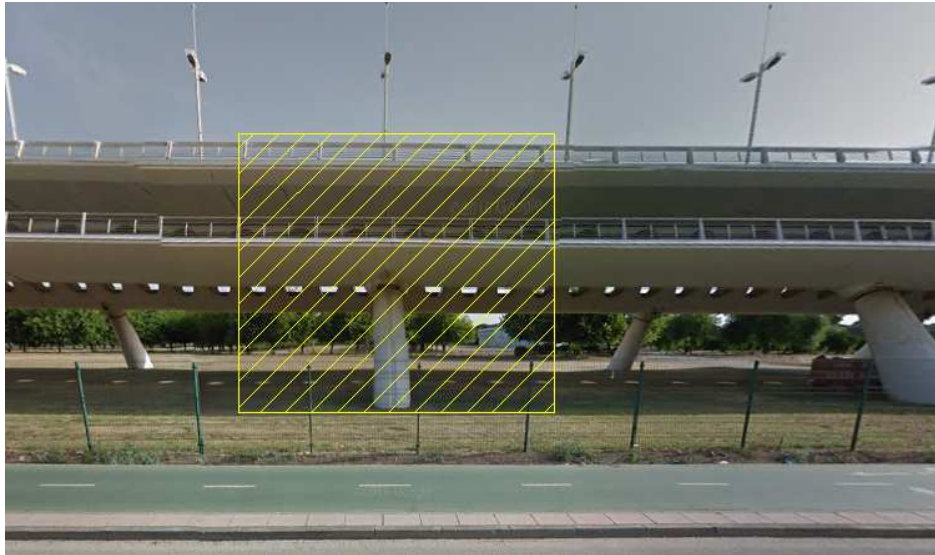
Ilustración 89. Zona de inspección del viaducto
