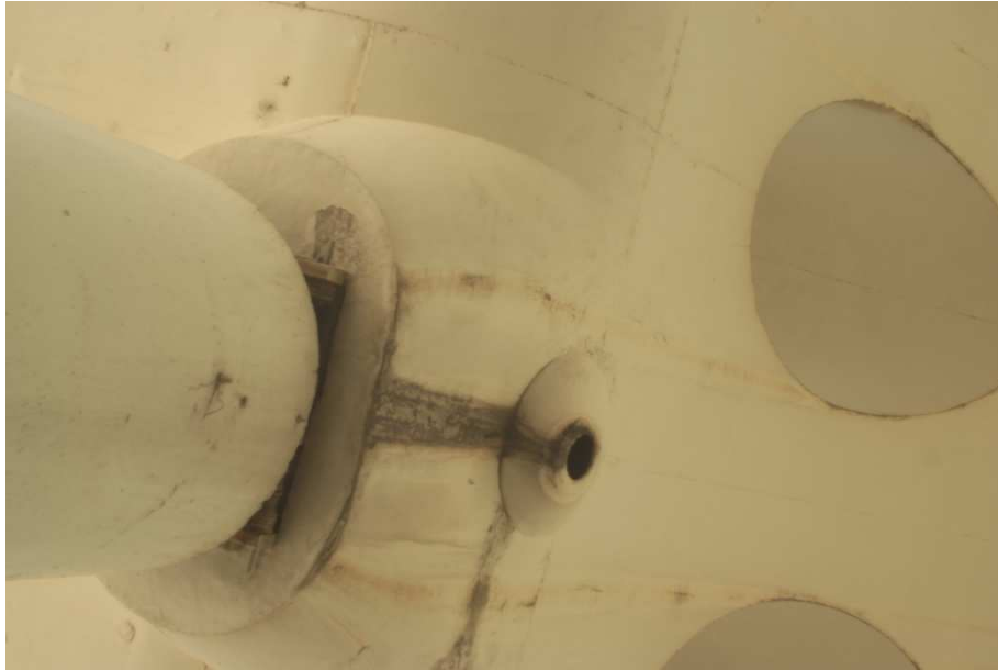
Ilustración 57. Imagen real de la vista inferior del viaducto
