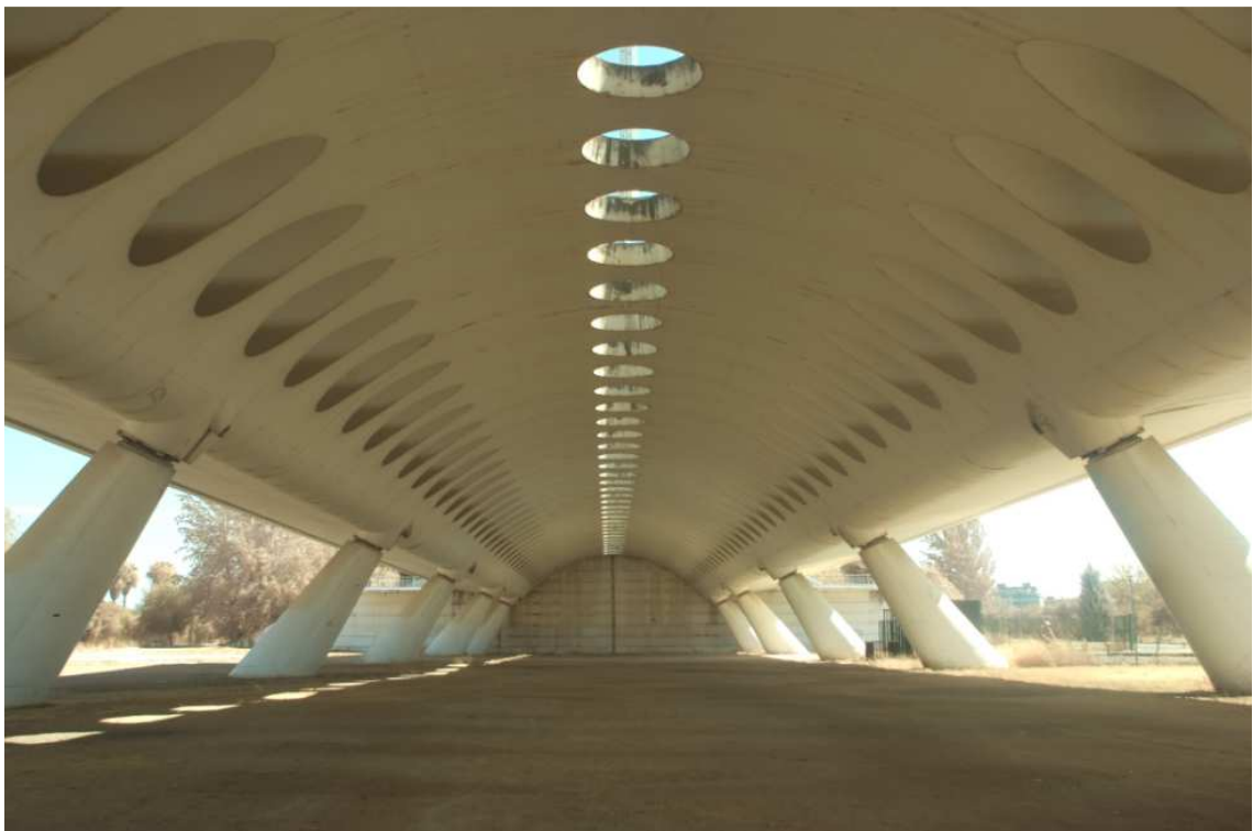
Ilustración 47. Vista inferior del viaducto de la Cartuja.
