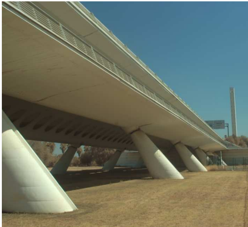
Ilustración 48. Vista lateral del viaducto de la Cartuja.
