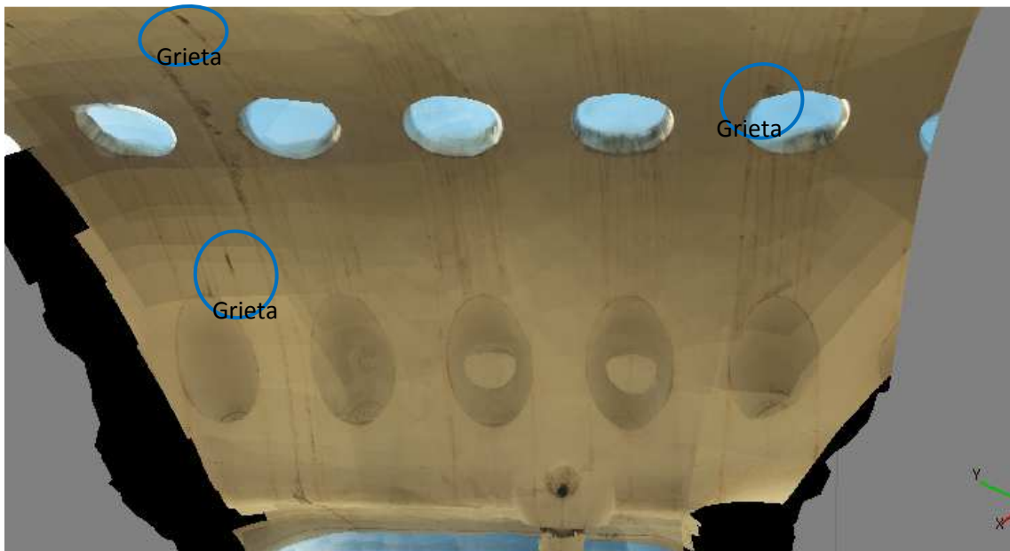
Ilustración 96. Patologías detectadas en el viaducto (5)
