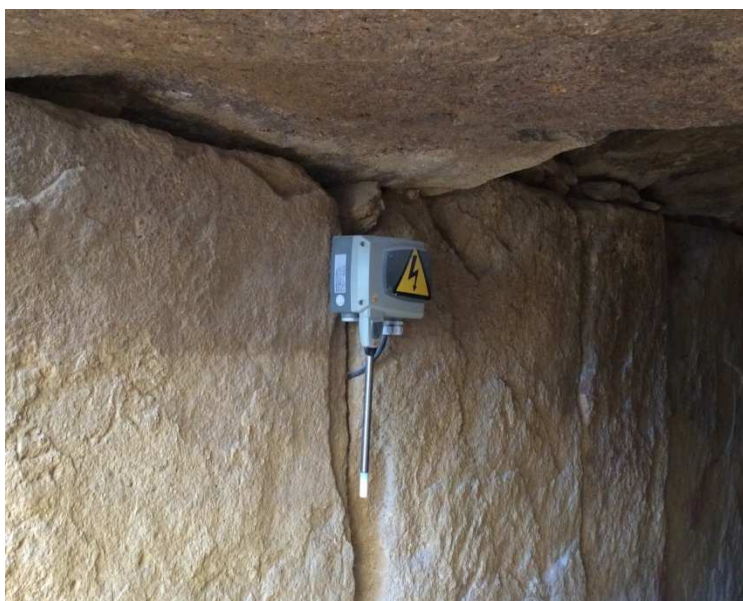
Figura 8.4. Medidor de humedad en el interior de Menga. Fuente: Elaboración propia. 29/10/2016.
