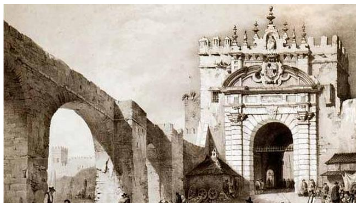
Figura 5.2. Caños de Carmona y Puerta de Carmona
