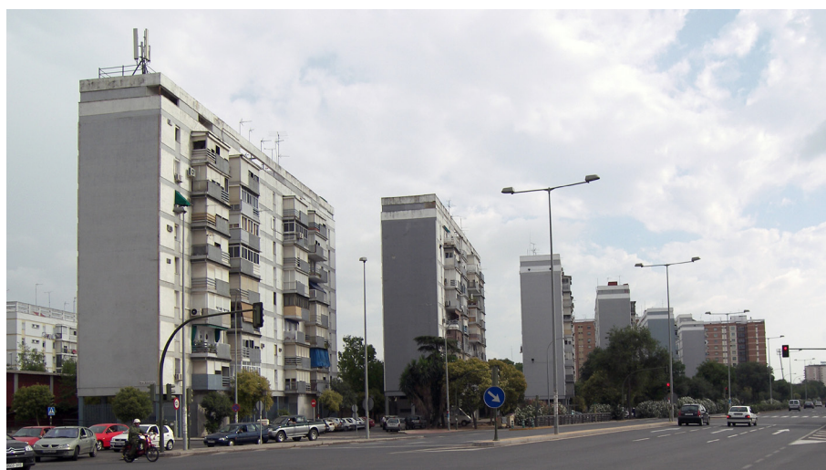
Bloques apantallados del Barrio E hacia la Avenida Kansas City (autopista de San Pablo), del arquitecto Ignacio Costa Walls. Año 2013. Fotógrafo Clemente Delgado.
