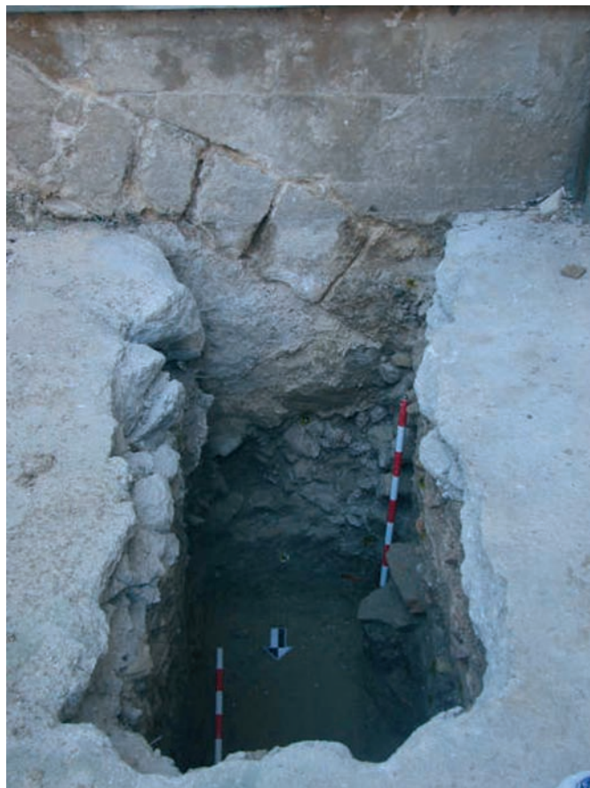
Fig. 9. Cata nº 2. Registro de la cimentación de la capilla. Se verifica la continuidad del arco hasta el cimientado del estribo
