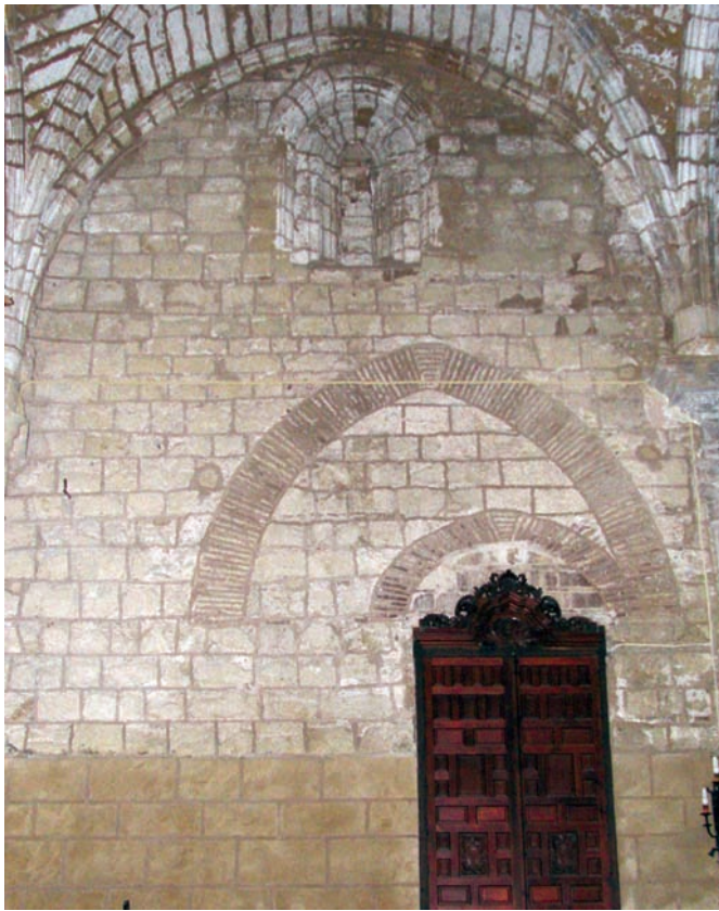
Fig. 10. Arco de descarga en el paramento A01 para construir el cimiento de la torre
