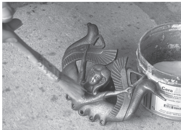
Lám. 43: Fijación de la pátina mediante cera.
