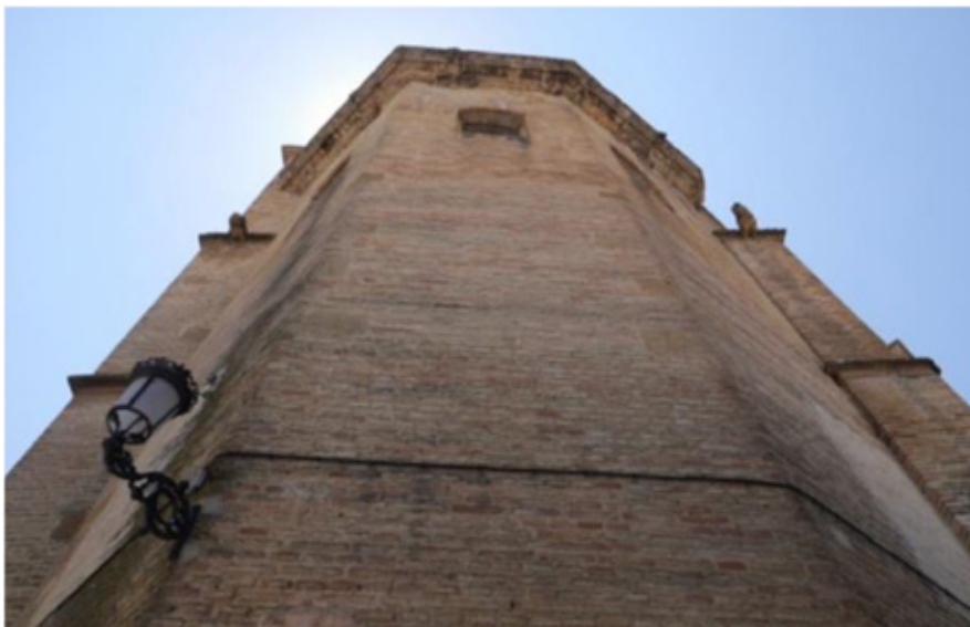
Figura 4. Vista exterior de la capilla.
