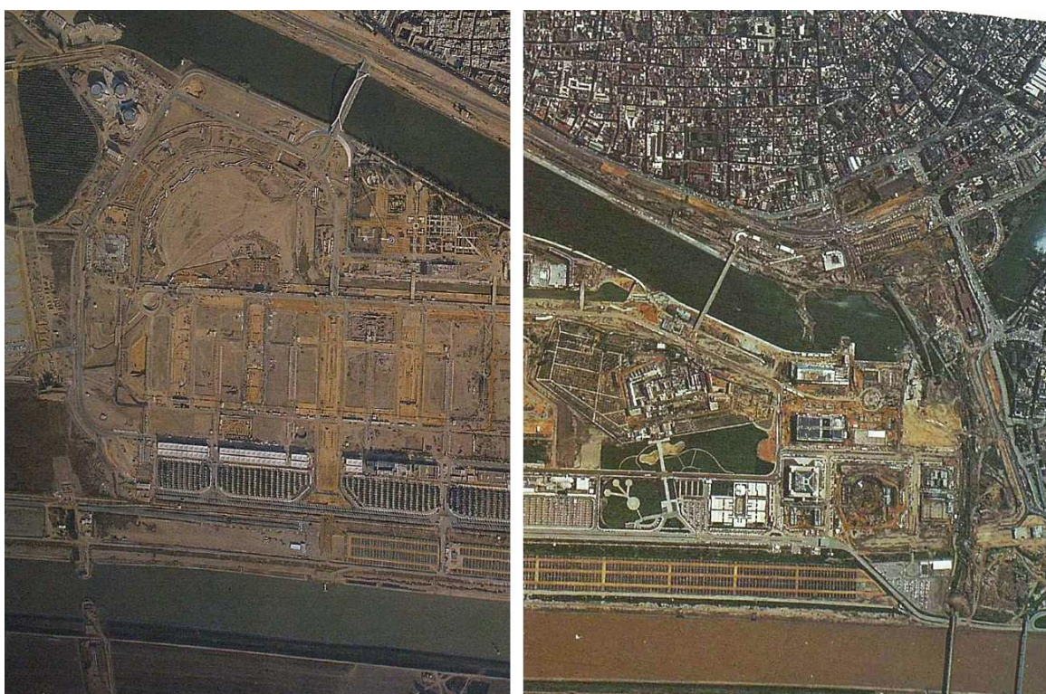
El avance de las obras en la isla de la Cartuja en tan solo siete meses. Izquierda: octubre de 1990. Derecha: mayo de 1991. Fuente: Archivo General de Andalucía.
