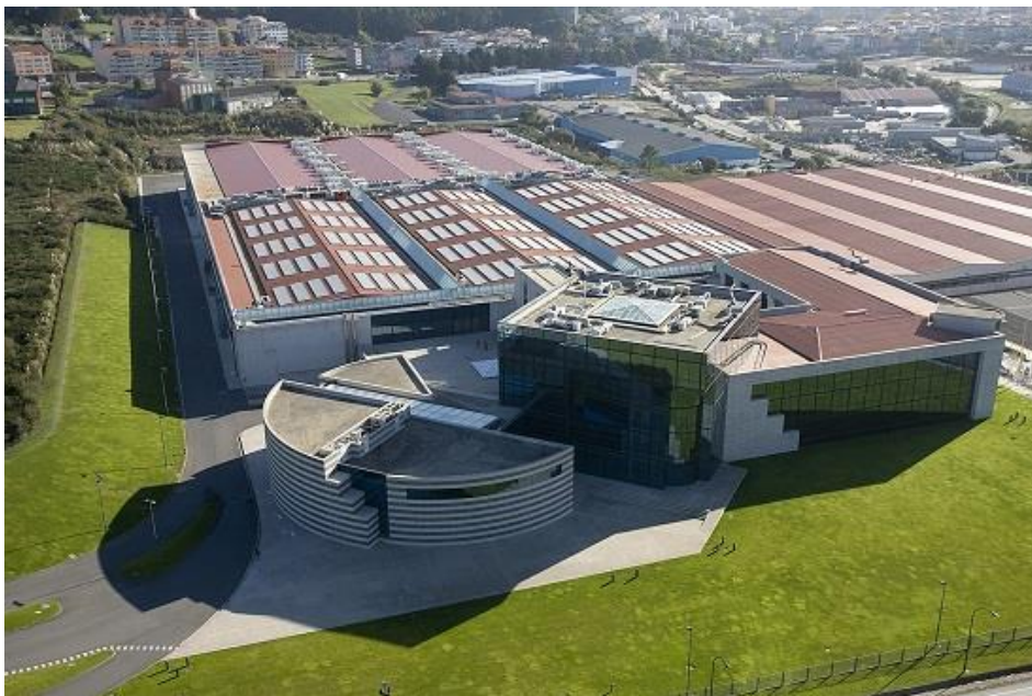
Figura 31: Vista de la superficie de captación del edificio fundación Inditex en Arteixo [27]
