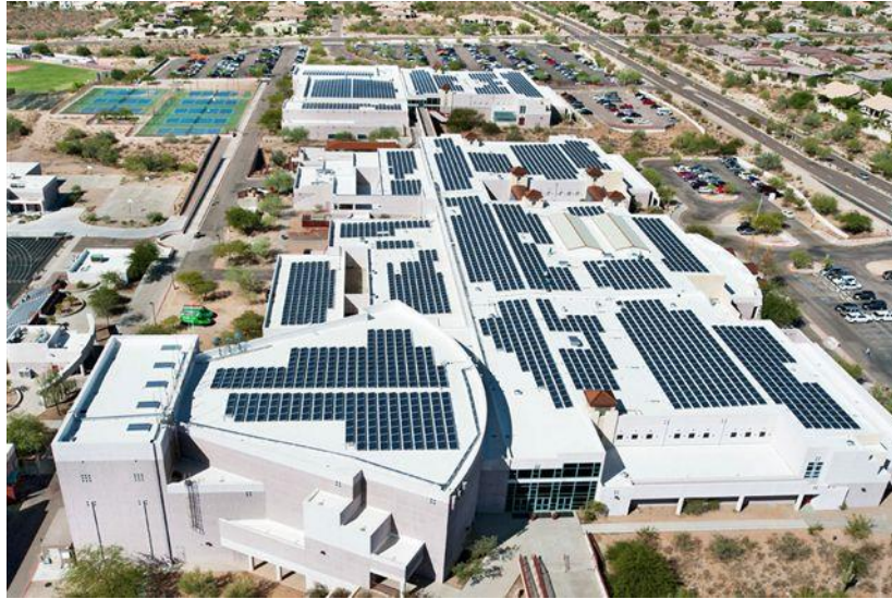
Figura 30: Vista de la superficie de captación del colegio Desert Mountain en Arizona [27]
