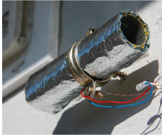
Figura 9: Protección para sensor de temperatura de la cámara exterior
