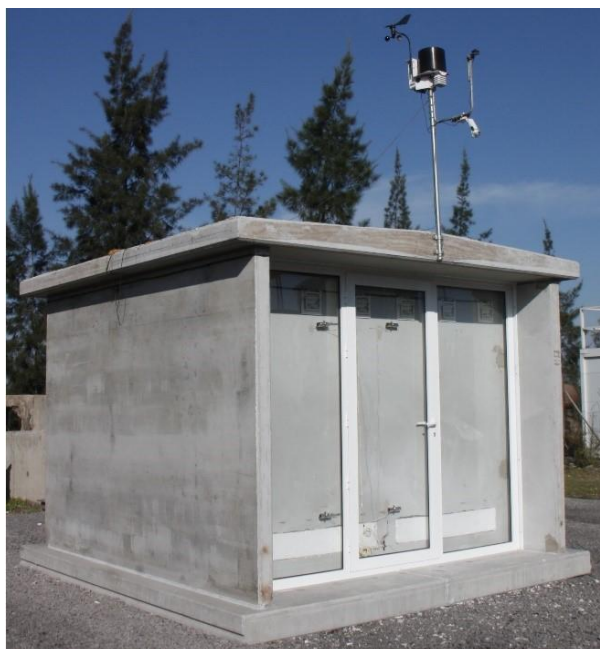
Figura 14: Caseta en modo fachada activa
