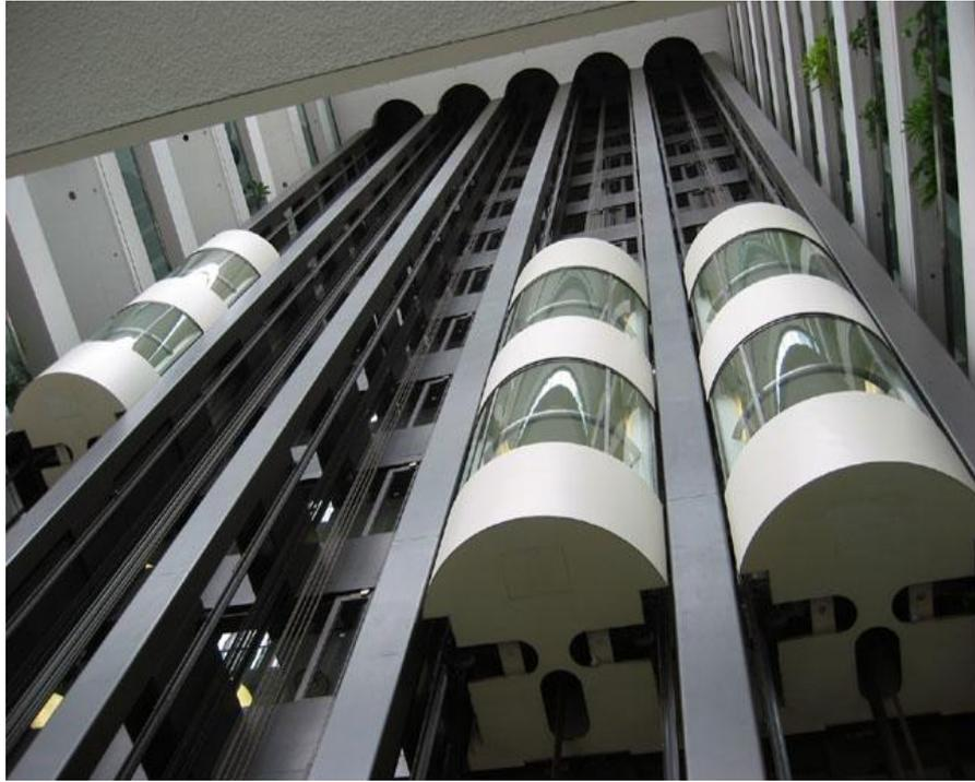
**Figura 14:** Sistema de ascensores *Double Deck*
