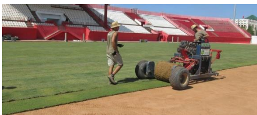
Figura 3-2: Instalación de tepe en superficie deportiva
