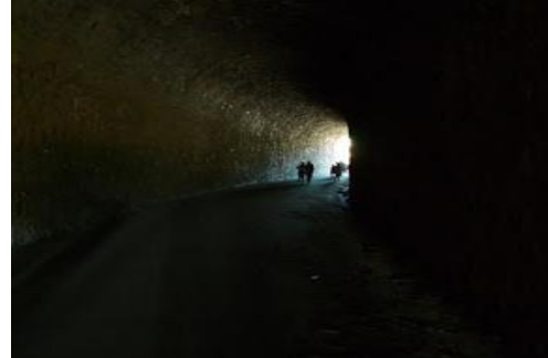
Imagen 3.11. Túnel Los Molinos. Fuente: Google
