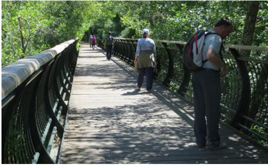
Imagen 3.10. Pasarela ubicada en la VVSN. Fuente: Google
