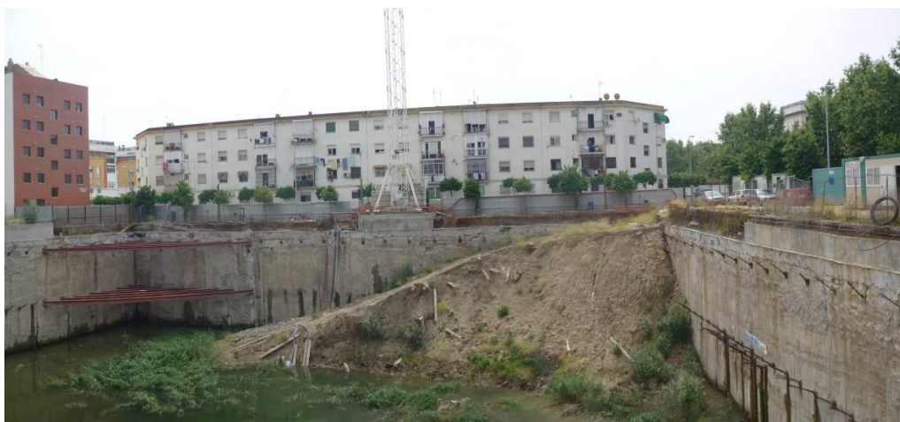
Figura 6.7. Disposición de la rampa de acceso al fondo de la excavación (Ferreira, 2016)
