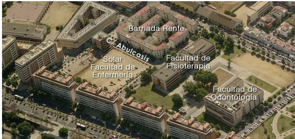
Figura 6.6. Imagen aérea del Campus Ciencias de la Salud antes del inicio de las obras de la Facultad de Enfermería. (Ferreira et al. 2016)
