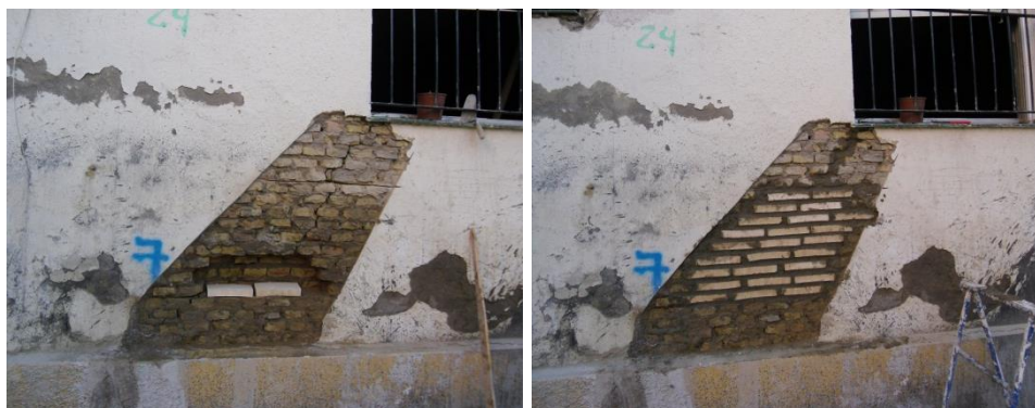
Figura 6.14. Reparación de grietas mediante retacado. (Ferreira, 2016)
