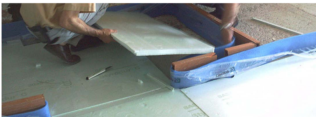
Ilustración 6-5: Instalación de aislantes
