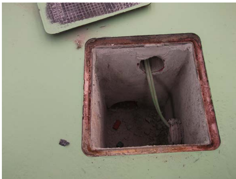
Ilustración 2-10: Detalle arqueta de registro
