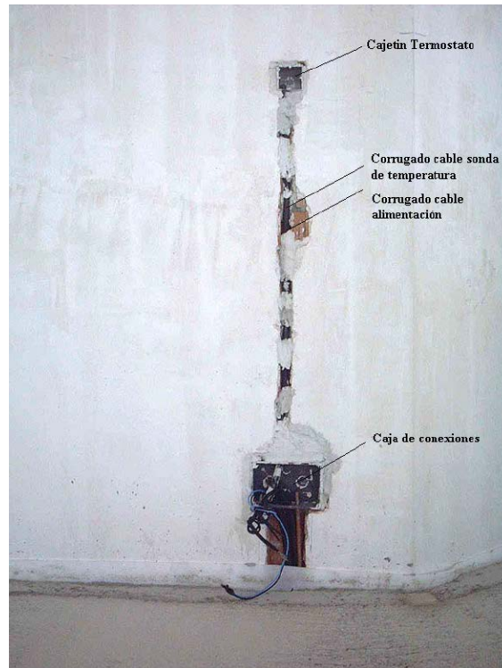
Ilustración 6-10: Caja de conexiones y termostato
