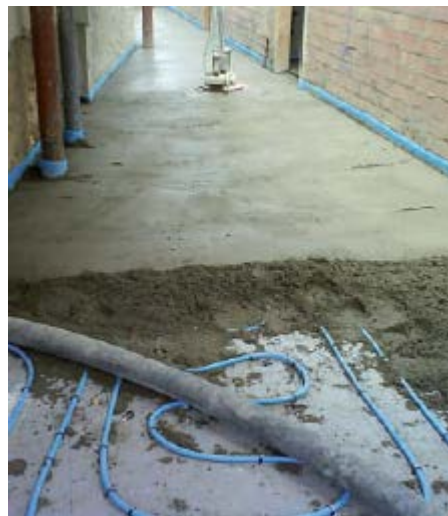
Ilustración 5-19: Vertido del mortero
