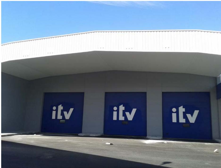
Ilustración 2-8: Fotografía de la cubierta
