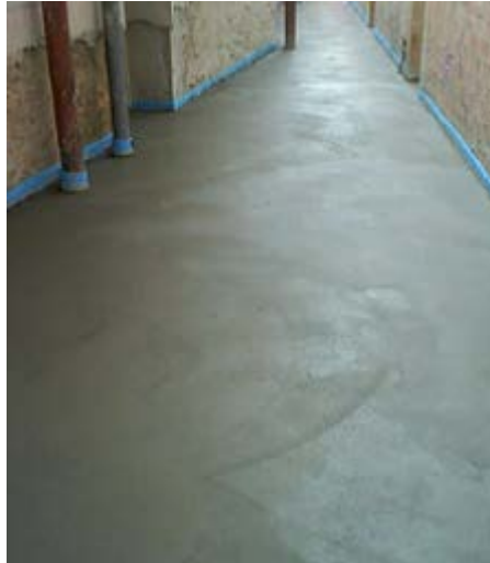
Ilustración 5-20: Cemento con tratamiento superficial de fratasado
