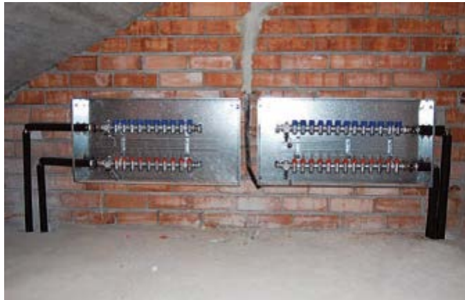
Ilustración 5-15: Sistema de colectores
