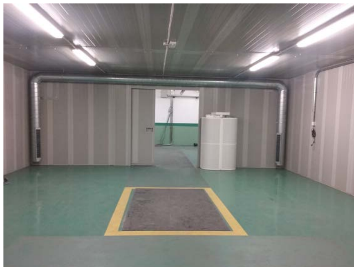
Ilustración 8-1: Puerta rápida en la Estación de El Pino (Sevilla)
