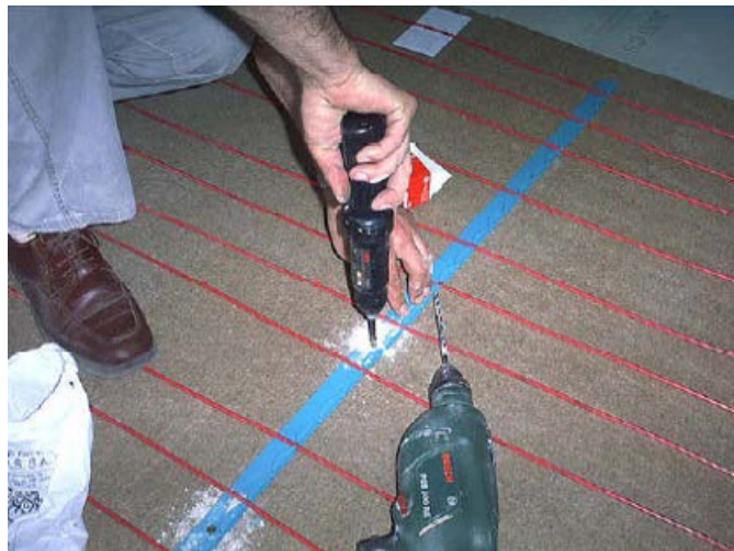
Ilustración 6-7: Instalación guía de separación
