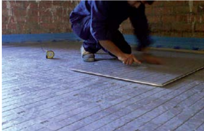
Ilustración 5-17: Colocación de paneles aislantes
