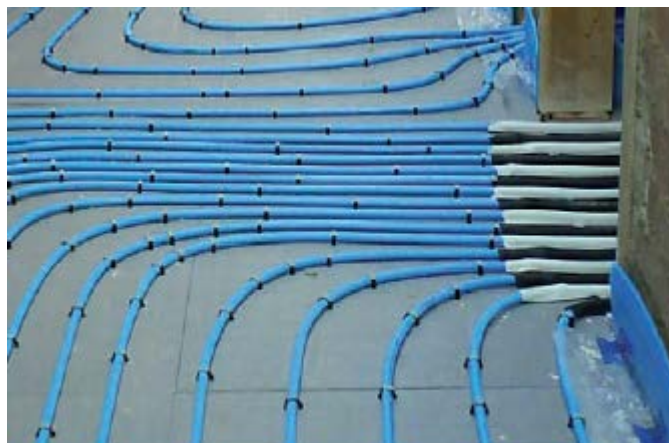
Ilustración 5-18: Instalación de tubos emisores
