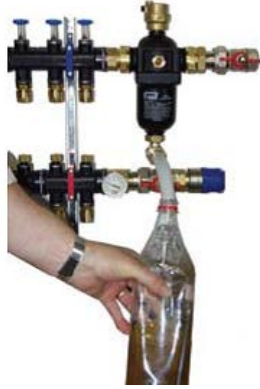
Ilustración 5-12: Limpieza de la instalación
