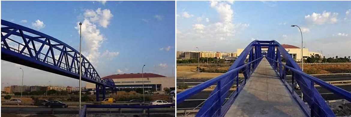
Figuras 1.3 y 1.4. Pasarela sobre la A-7 de Málaga frente al estadio Martín Carpena
