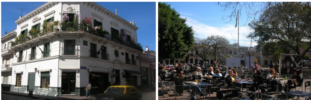
Figuras 13 y 14: Edificio de la calle Defensa y plaza Dorrego (Barrio de San Telmo). Fuente: Emilio José Luque Azcona (2008).
