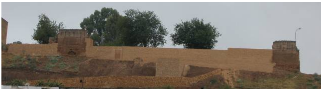
Fig. 6. Vista general del lienzo norte de la Muralla de la Villa, Alcalá de Guadaíra, Sevilla (créd. Martín Molina y Díaz Recasens).
