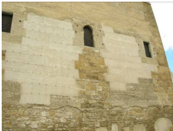
Fig. 5. Reparación de tapia a una cara en el Alcázar de la Pta. de Sevilla, Carmona (Créd. los autores)
