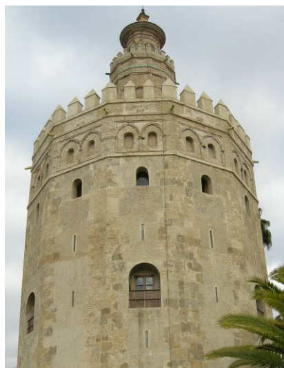
Fig. 8. Vista de la Torre del Oro después de la intervención de 2004 (créd. los autores).
