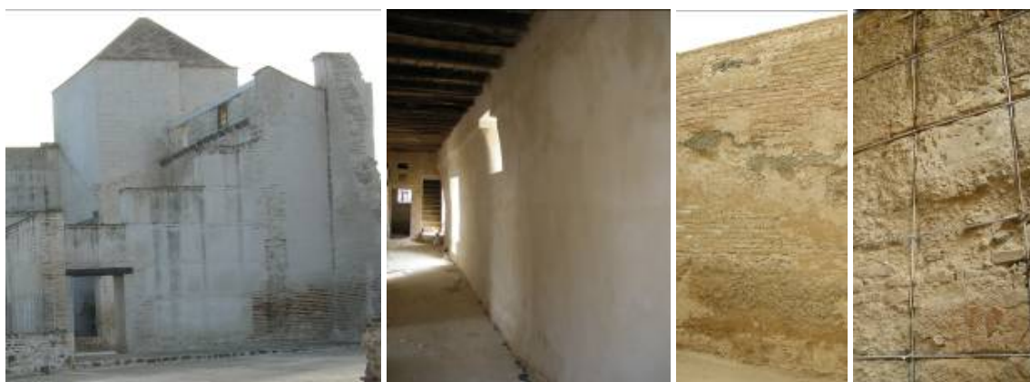
Fig. 9 a 12. De izquierda a derecha: (9) Vista general de las tapias de la hacienda; (10) vista interior de los lienzos revestidos con mortero de cal; (11) restituciones a una cara en la tapia por medio de ladrillo macizo; (12) refuerzo estructural de una tapia de la hacienda (créd. los autores).
