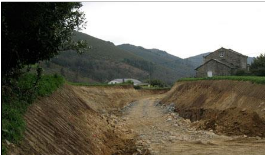
Ilustración 5 Terreno desnudo como consecuencia de la excavación de un desmonte
