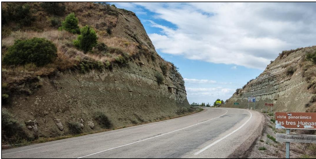
Ilustración 4 Ejemplo de desmonte en un corredor de una carretera
