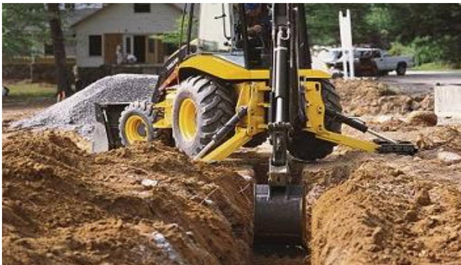
Ilustración 3 Ejemplo de excavación en zanja
