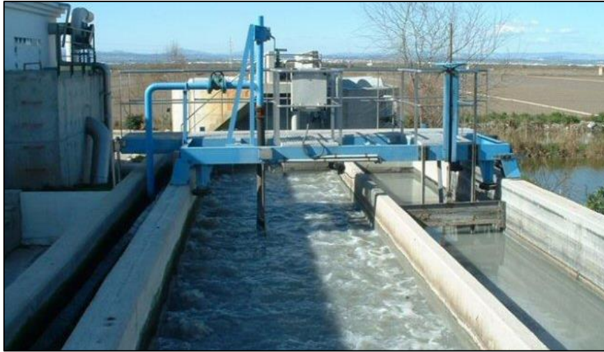
Ilustración 29 Desarenador-desengrasador
