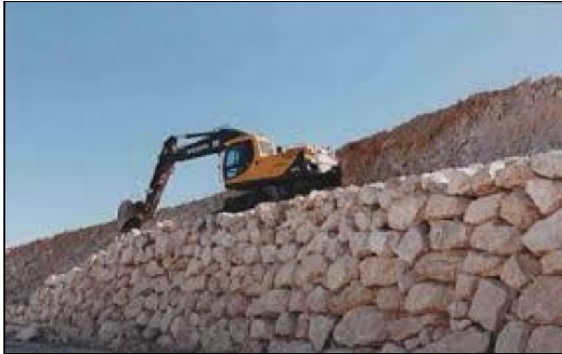
Ilustración 12 Ejecución de un muro de escollera
