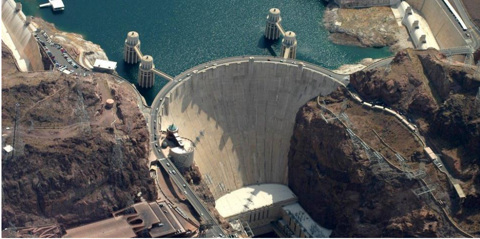
Ilustración 26 Presa de hormigón del tipo arco-gravedad
