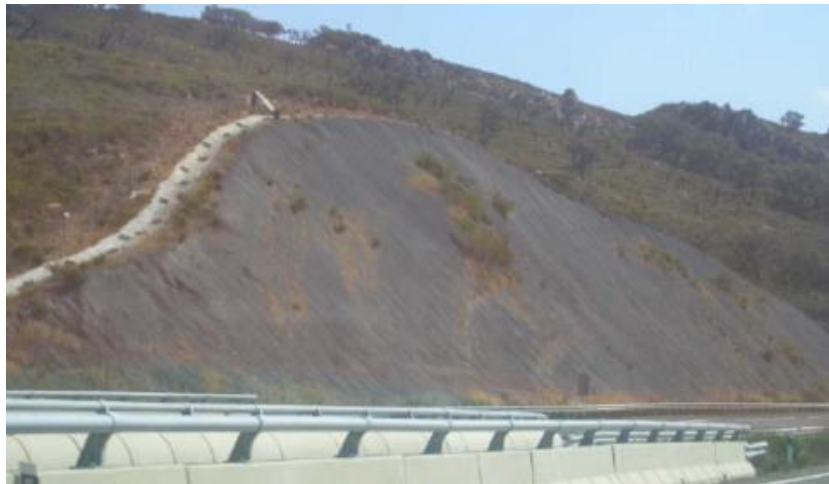
Ilustración 48 Mallas de torsión en desmonte
