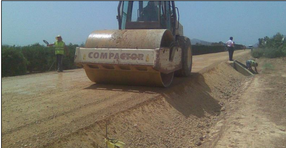
Ilustración 14 Rodillo compactador en la ejecución de las capas de la explanada
