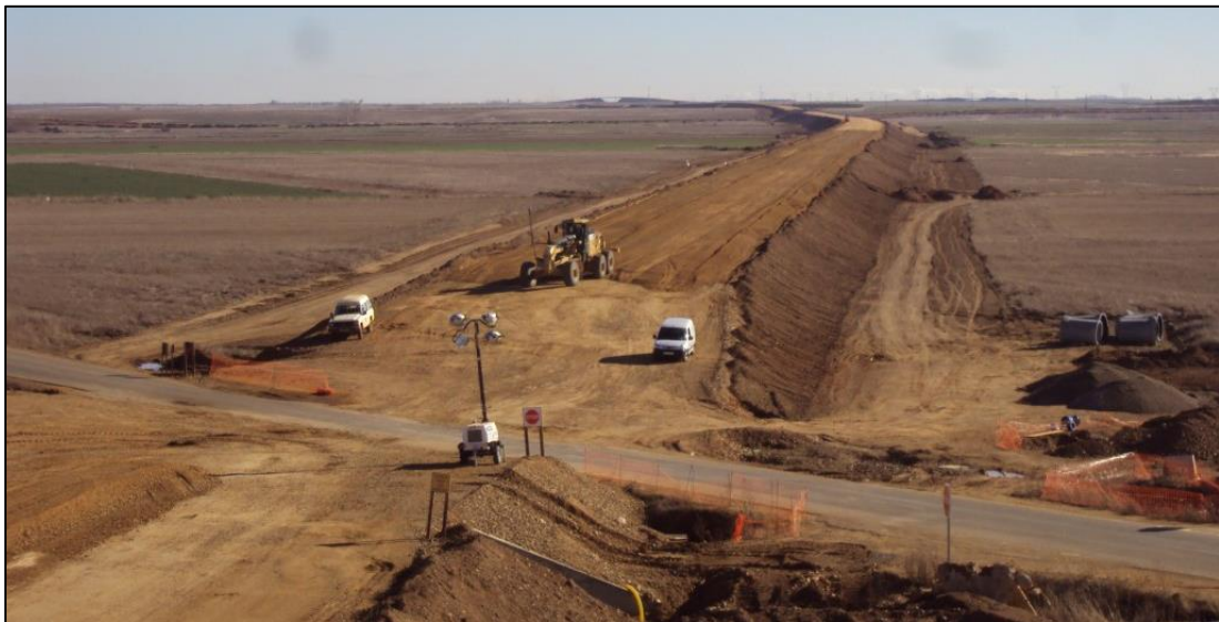
Ilustración 6 Creación del terraplén para la ejecución de la plataforma
