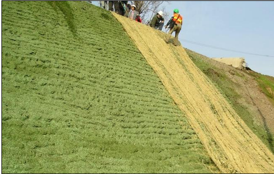
Ilustración 47 Revegetación de taludes con hidrosiembra
