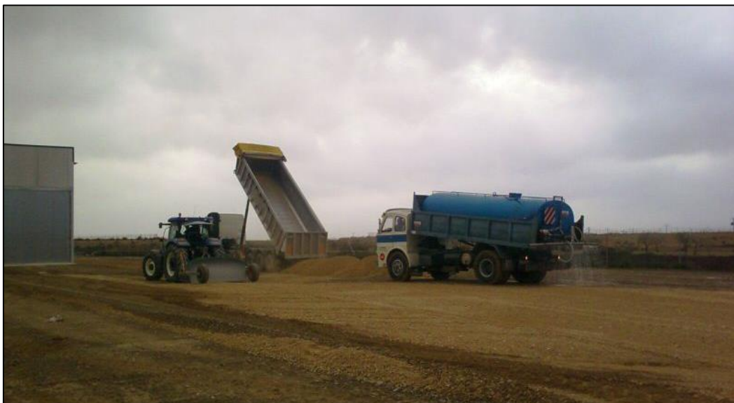
Ilustración 13 Extensión del material y regado para la ejecución de la base
