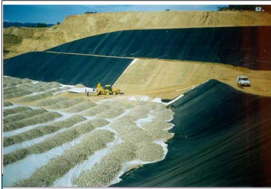
Ilustración 40 Obras de impermeabilización de un vertedero
