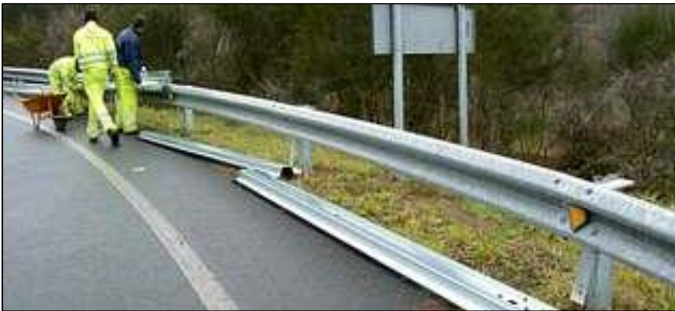
Ilustración 18 Instalación de la biondas
