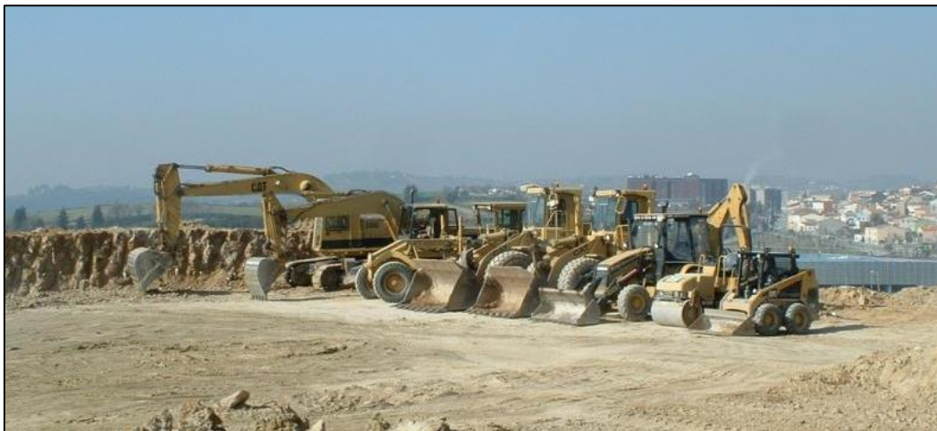
Ilustración 2 Parque de maquinaria
