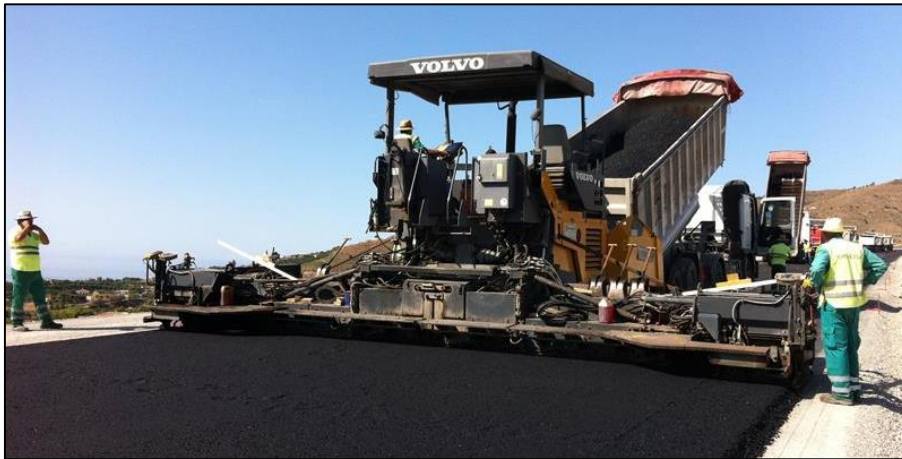
Ilustración 16 Extensión de las capas de rodadura
