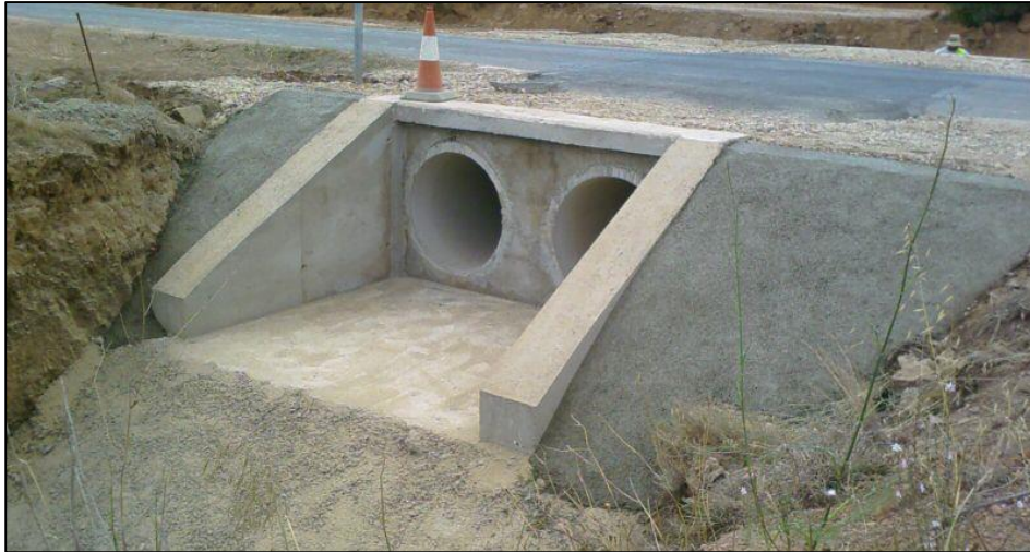
Ilustración 8 Obra de paso de drenaje transversal
