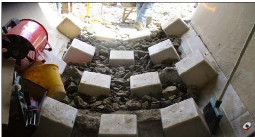
Ilustración 58 Obra de drenaje adecuada para la fauna
