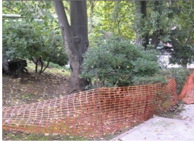
Ilustración 46 Jalonamiento con cintas plásticas
