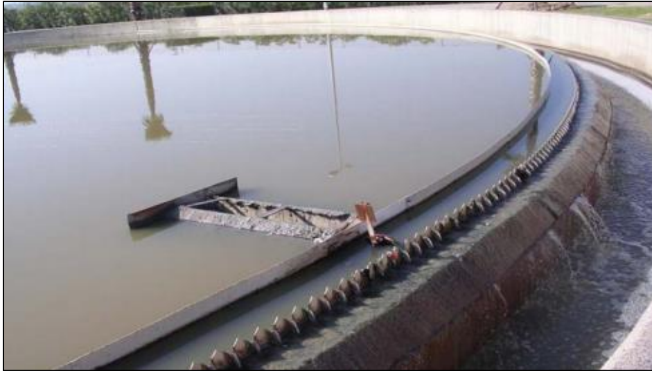
Ilustración 31 Decantador primario
