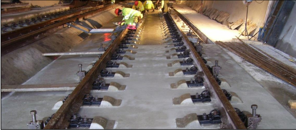
Ilustración 21 Vía sobre placa
