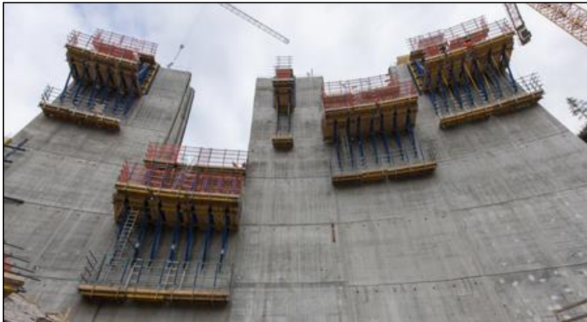
Ilustración 25 Encofradoras trepantes en la construcción de una presa
