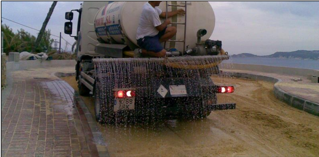
Ilustración 45 Riego de camino con camión cisterna
