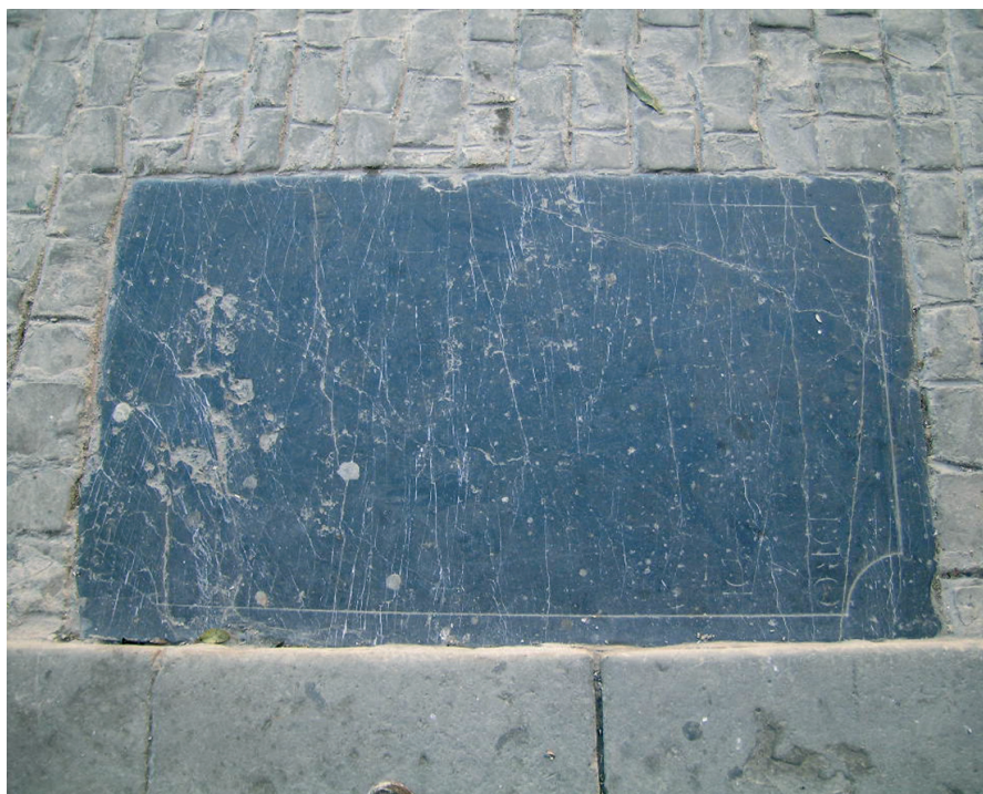
Lápida en el ingreso de la iglesia de Santa Marta. El material de las losas romanas existentes en el subsuelo de la plaza es similar al de esta piedra, por lo que no es descartable que para realizar la lápida se reutilizara una losa del pavimento romano.
