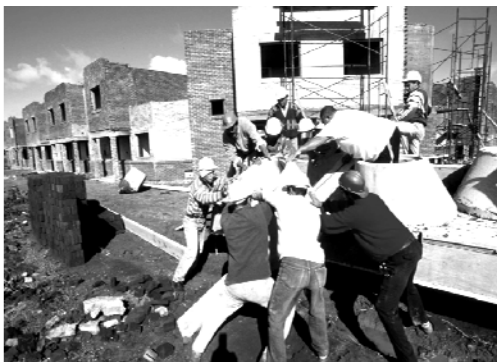
Obras de una cooperativa de la FUCVAM. Fotografías de Raúl Vallés y Benjamín Nahoum
