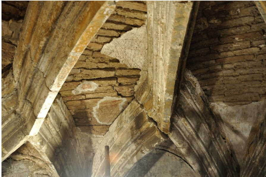
Figura 2-11 Detalle fisura
