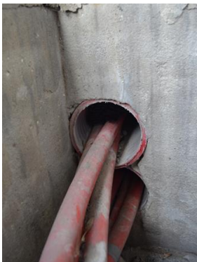
Figura II.3: Ejemplo de línea subterránea.
