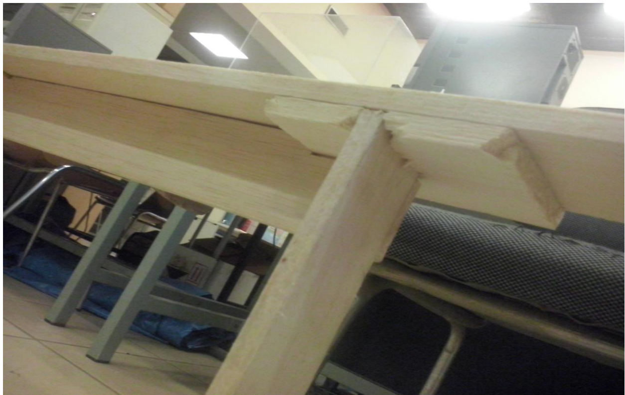
Fig 3.14 perfil en T y unión patas con perfil alto
