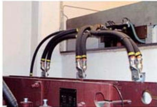
**Figura 23.** Reducción de longitud en conductores de baja tensión [12].
