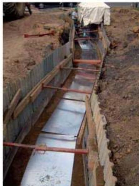
**Figura 19.** Colocación de pantallas de aluminio en tendido subterráneo [12].
