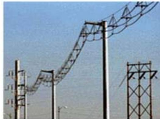
**Figura 12.** Configuración compacta triangular en línea de 66 kV.
