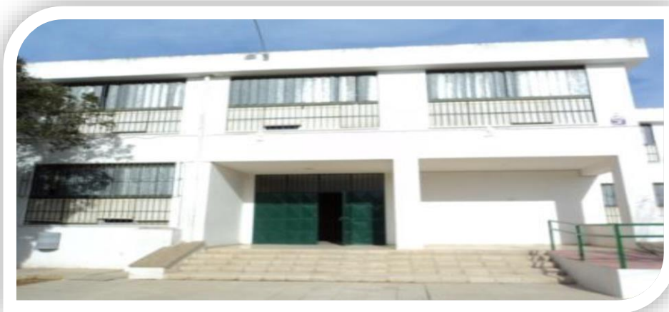
Imagen 4. Entrada al edificio de Doña Amparo.
