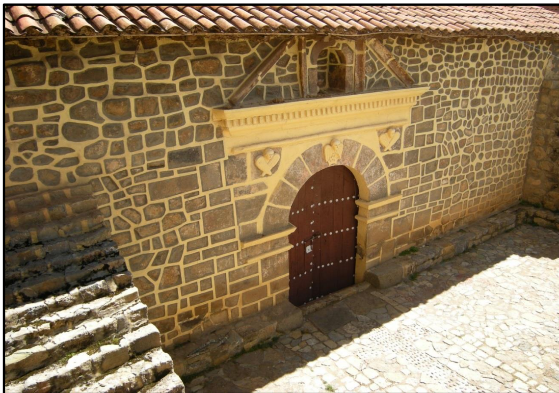
Figura 32. Fachada lateral de la iglesia
