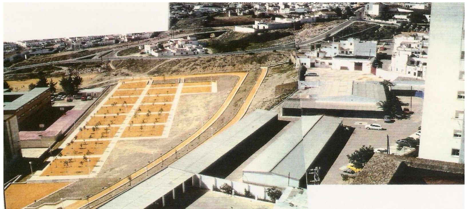
Foto 6: Parque público en esquina suroeste (año 1991 P.E.R.I. 2F)
