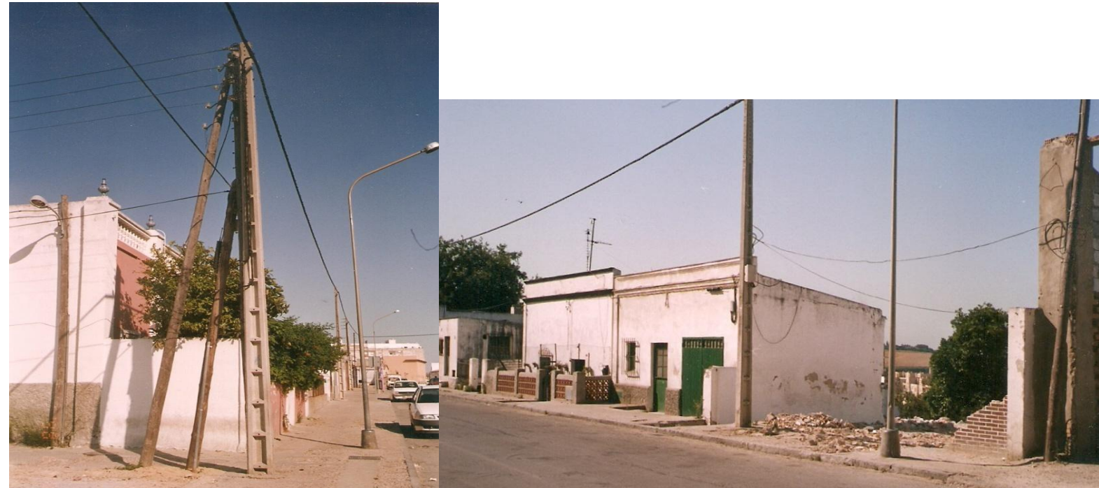
Foto 16: Tendido eléctrico aéreo en calle Obispo Cirarda en 1993 (archivo Emuvijesa)
