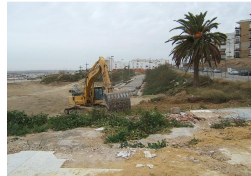
Foto 32: Obras de urbanización de la 5ª y 6ª fase Año 2012. (Archivo Emuvijesa)
